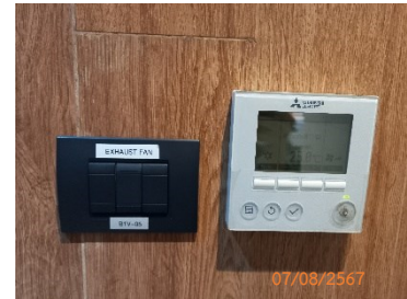
สวิตช์ควบคุมไฟฟ้าและเครื่องปรับอากาศ
